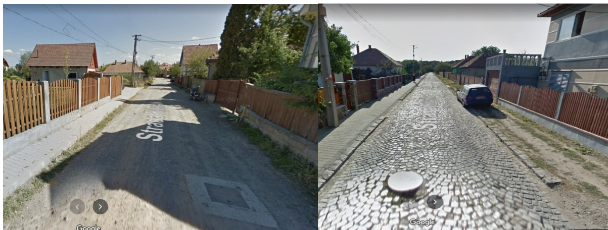
Figura 27. Imagine starea străzilor din categoria foarte slabă și foarte deteriorată
