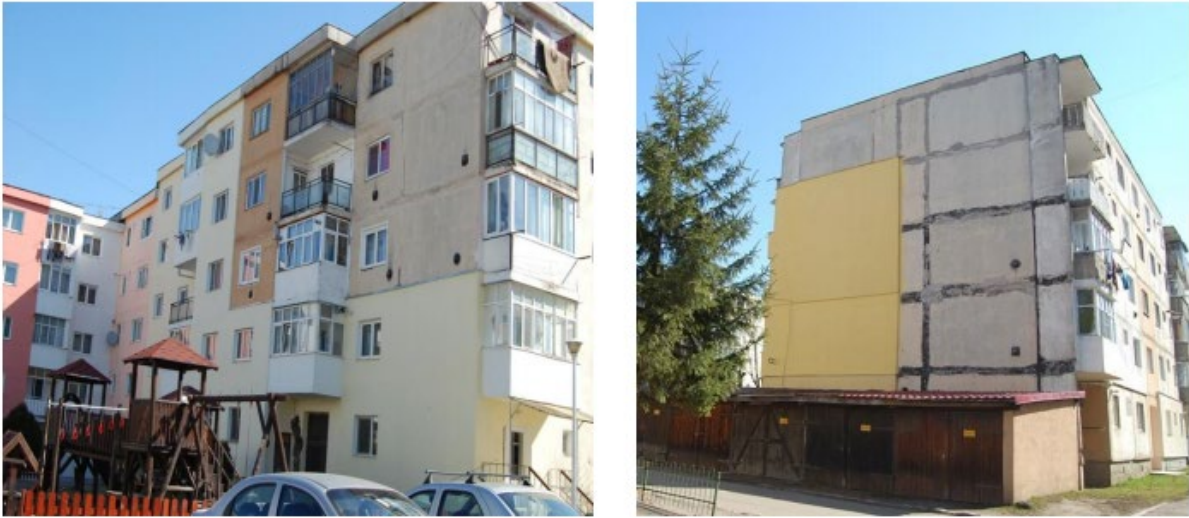
Figura 26. Reabilitare termică a blocurilor din Târgu Secuiesc
