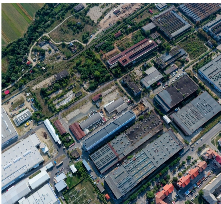
Figura 68. Vedere aeriană a parcului industrial Cugir
